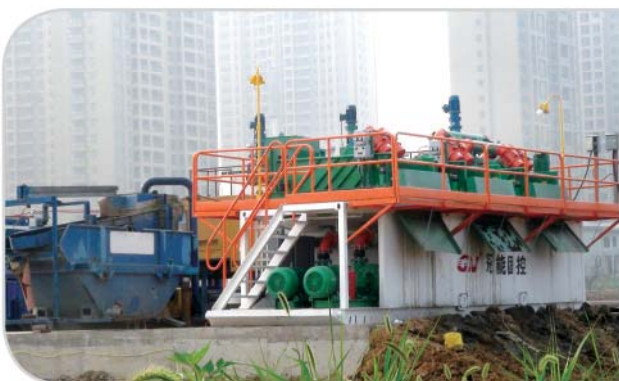
Dragado de lodos sólidos y separación de líquidos
