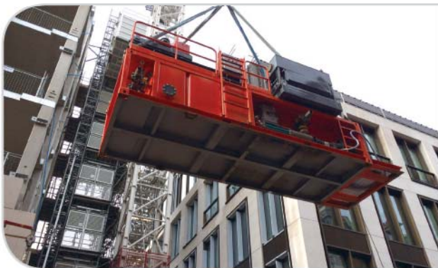
Limpieza de lodo de perforación de pozos geotérmicos
